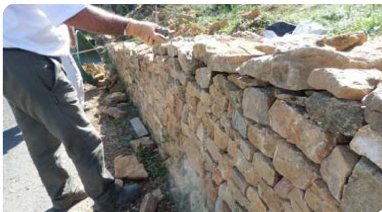
Contrairement à un mur de briques, le mur de pierres sèches est réalisé par assemblage, sans mortier, ce qui ne l'empêche pas d'être solide ; certains peuvent durer des centaines d'années.
